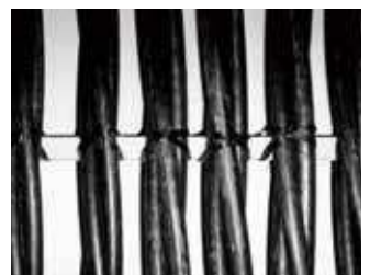
電設工事：電気設備垂直幹線結束例
