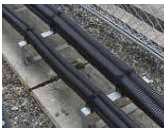
通信工事：携帯電話用給電線結束例
