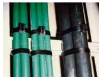
電設工事：電気設備垂直幹線結束例
