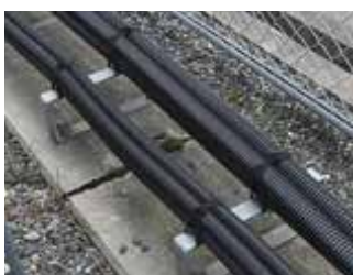
通信工事：携帯電話用給電線結束例
