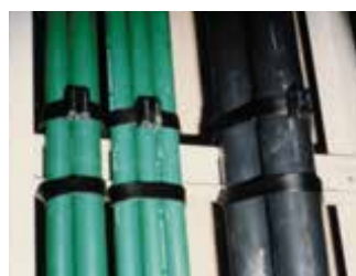
電設工事：電気設備垂直幹線結束例
